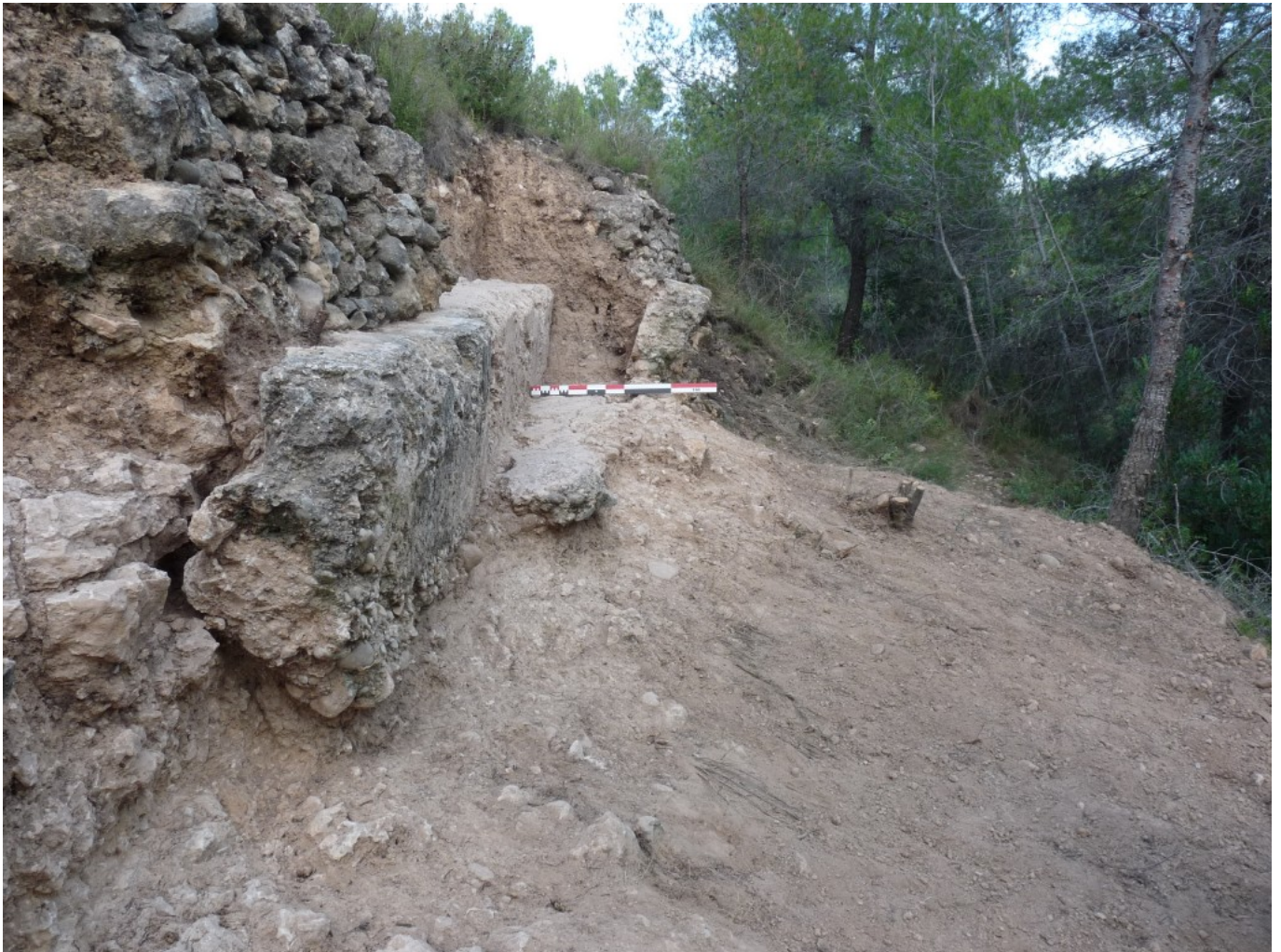
Excavació al primer tram de l'aqüeducte, al terme d'Aiguamúrcia (Alt Camp). És un dels pocs llocs on encara s'aguanta la paret lateral. Foto © ICAC
