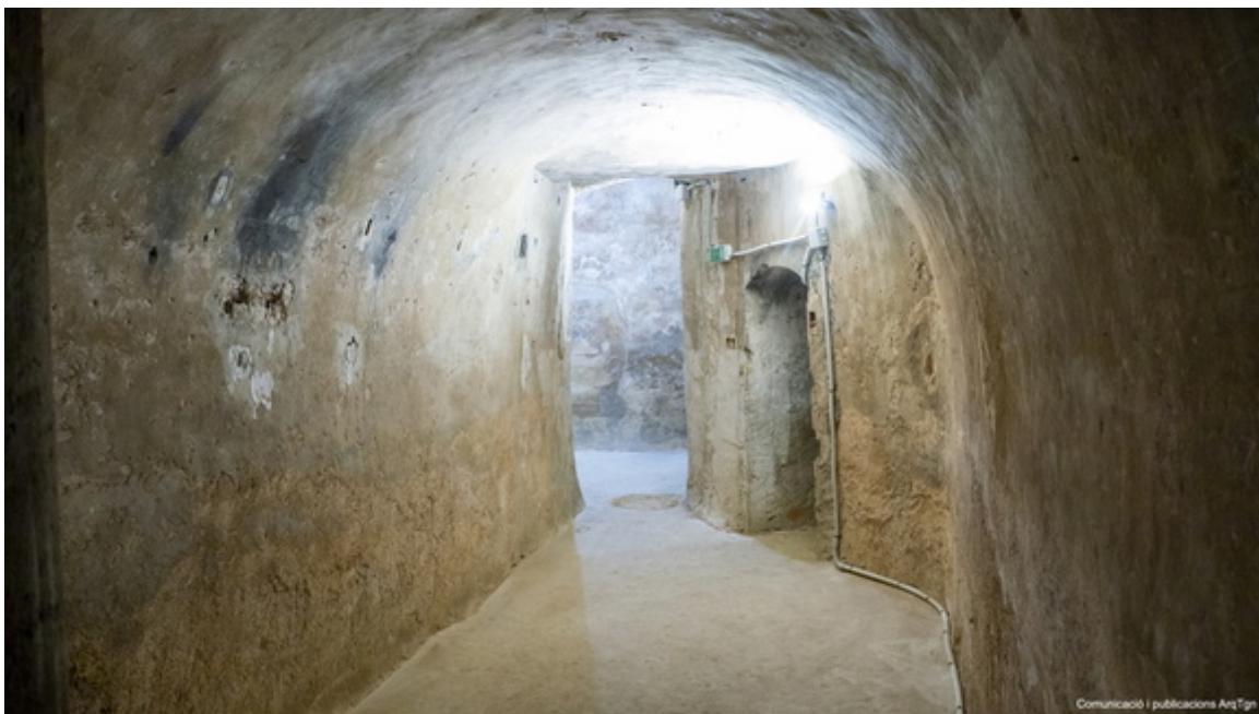
Imatge de les galeries del subsol. Foto: Arquebisbat de Tarragona, Santi Grimau.
