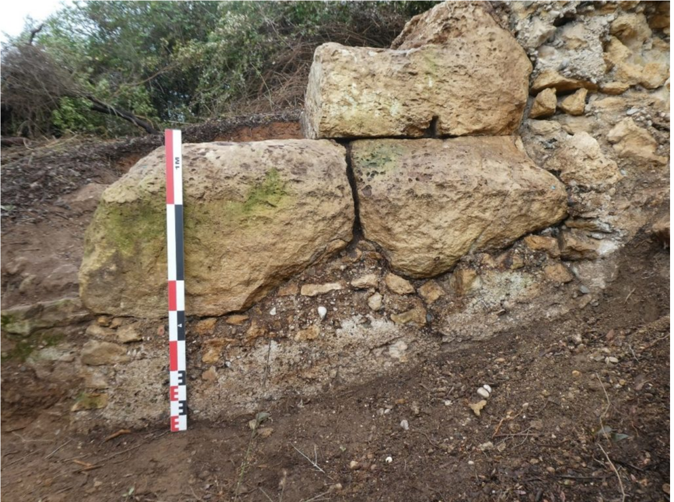
Estrep nord del Pont del Tupino, amb els blocs suposadament procedents de la nova pedrera. Foto: ICAC (CC 4.0).
