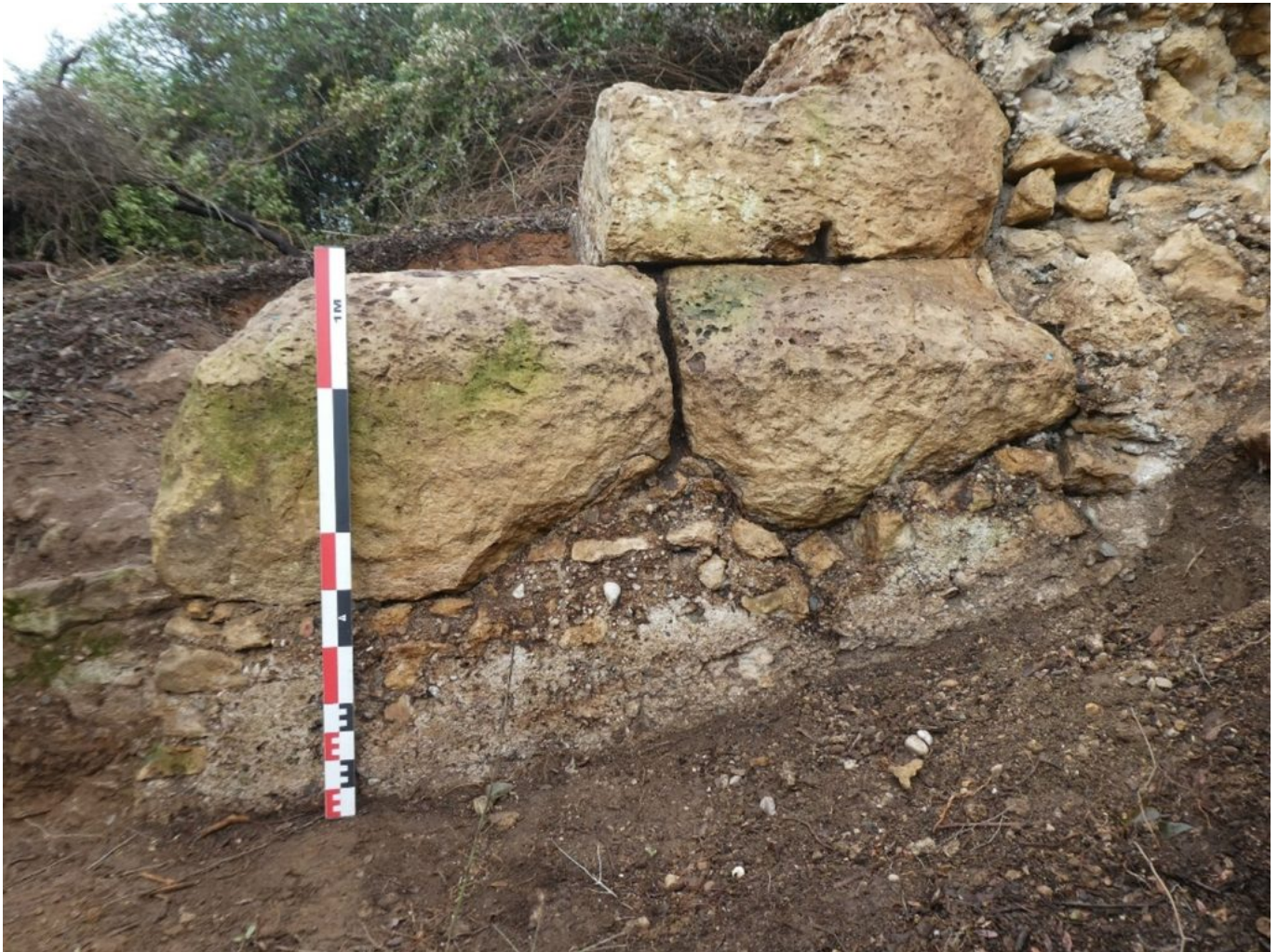
Estrep nord del Pont del Tupino, amb els blocs suposadament procedents de la nova pedrera. Foto: ICAC (CC 4.0).
