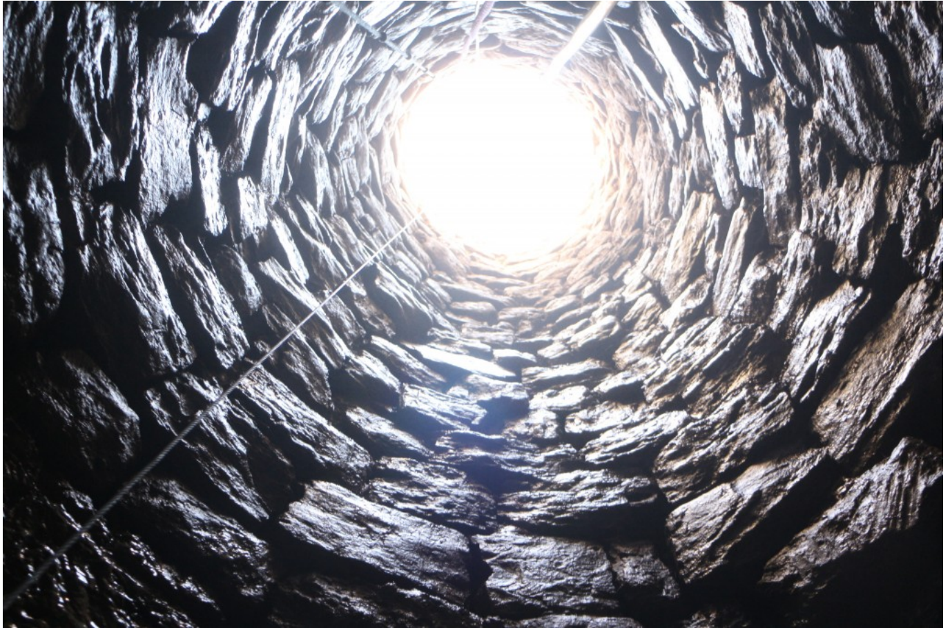
Vista de l'interior del pou (@ Equip Iesso)
