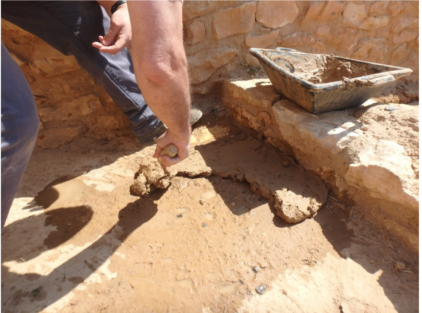
Construcció experimental d'una llar protohistòrica, en un espai exterior, fent servir una capa de fang dipositada directament sobre el sòl i en un espai exterior. Foto: projecte TRANSCOMB (ICAC).
