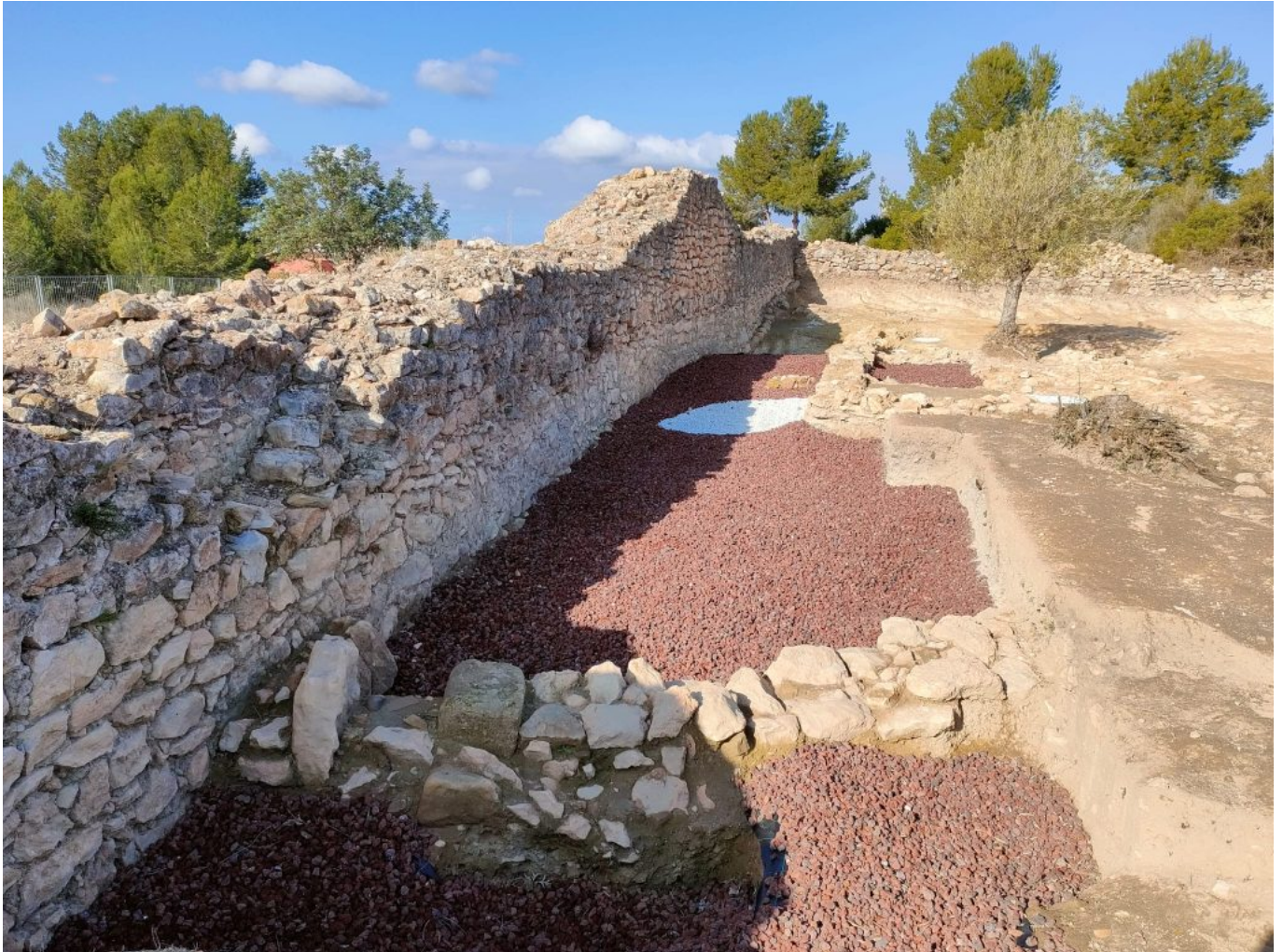
Al jaciment de València “la Vella” (Ribera-roja de Túria, València) s’estan duent a terme obres d’acondicionament per a fer-hi visites guiades. Foto: ICAC, 2022 (CC BY 4.0).
