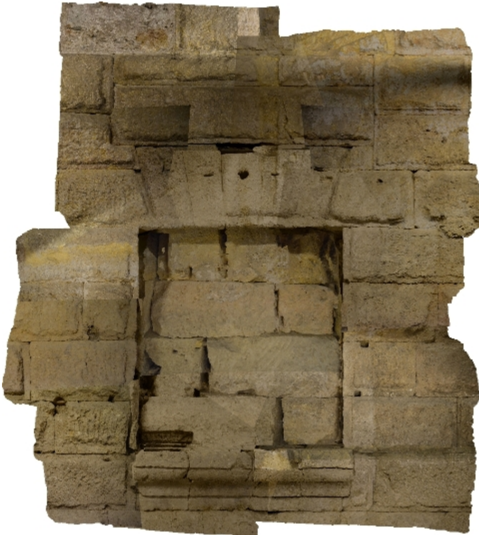
Ortoimatge de la finestra central del fragment de mur romà obtingut per fotogrametria.
