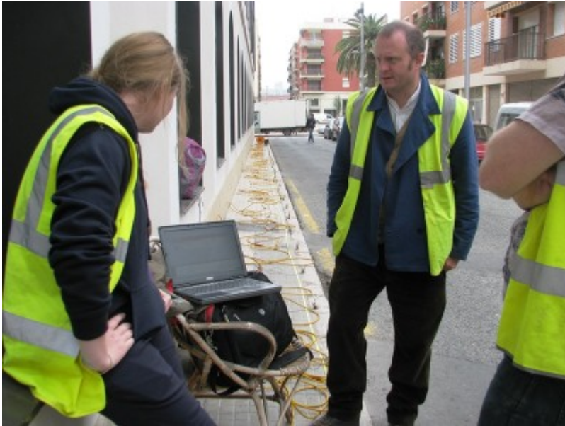
Prova de tomografia al carrer del Vapor.
