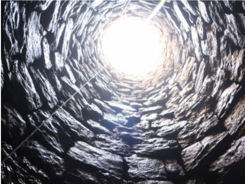
Vista des de l'interior del pou.
