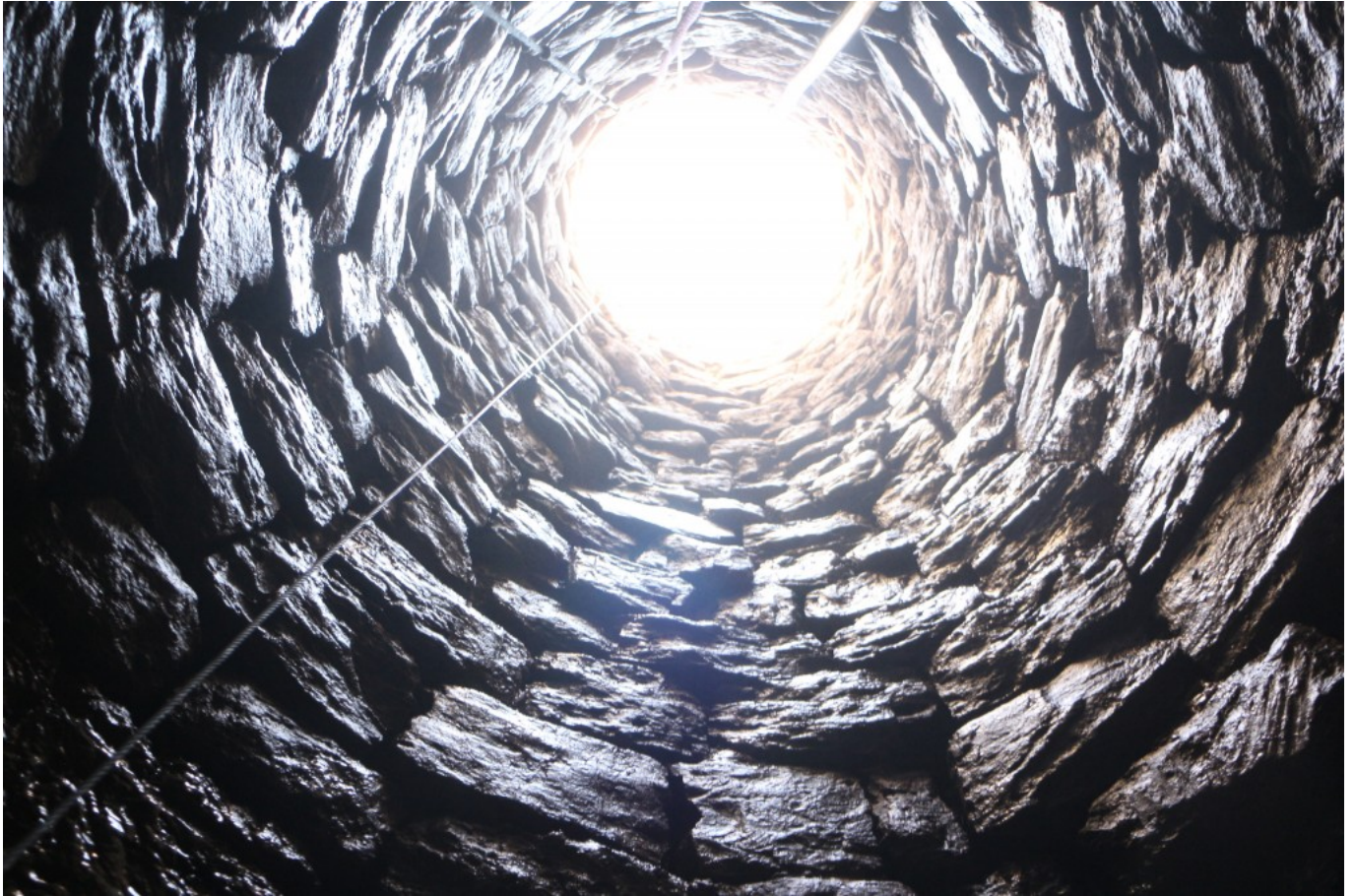
Vista del interior del pozo (@ Equipo Iesso)
