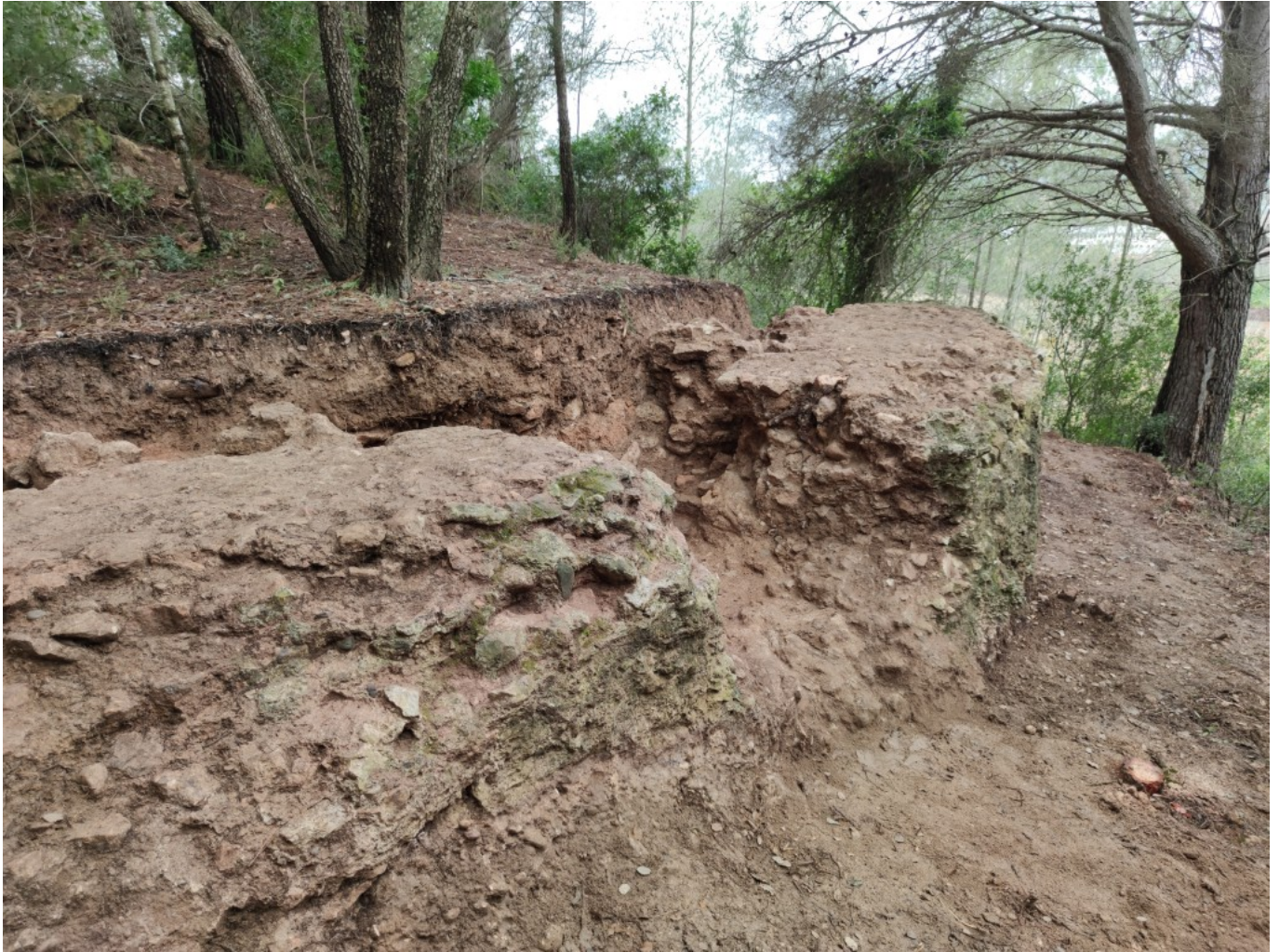
Excavación en el contrafuerte del segundo tramo del acueducto, en el término de Vallmoll (Alt Camp). Foto © ICAC
