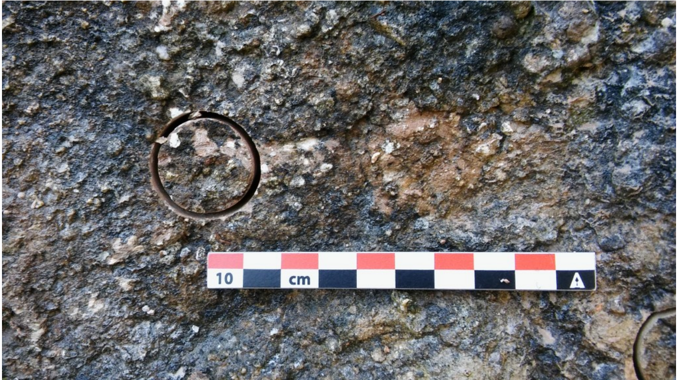
Detalle de la muestra antes de su extracción. Foto: ICAC.
