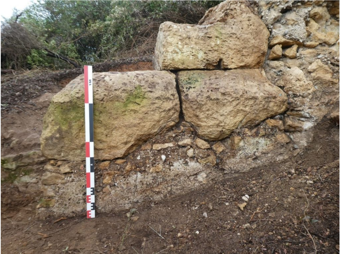
Estribo norte del Puente del Tupino, con los bloques supuestamente procedentes de la cantera ahora descubierta. Foto: ICAC (CC 4.0).
