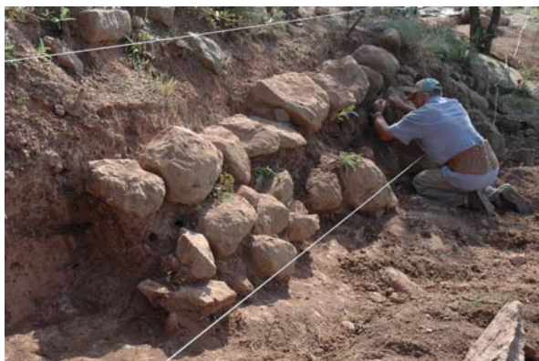
Neteja i sanejament de la muralla W
