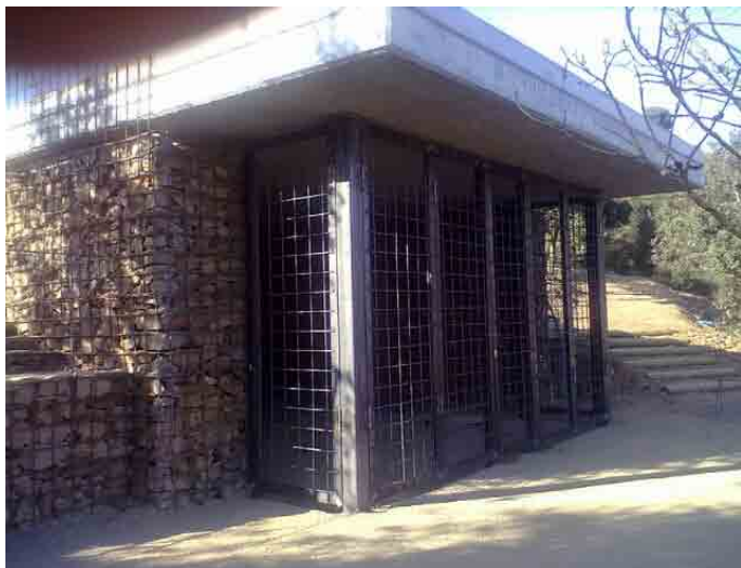
Estat de les obres gairebé finalitzades de l'edifici del Centre d'Interpretació
