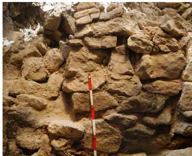
Detall de la tècnica constructiva d'un mur del període Nù-mida Antic
