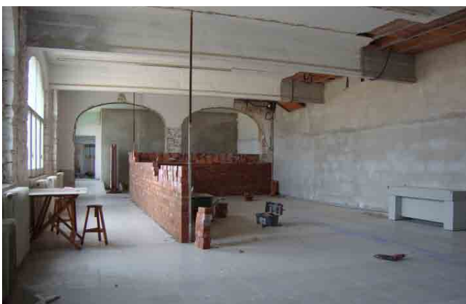
Obres de construcció del museu i centre d'interpretació de Iesso (Guissona)
