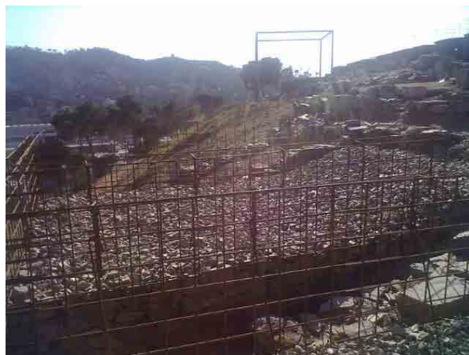
Aspecte de les obres de museïtzació de Can Tacó realitzades el 2011
