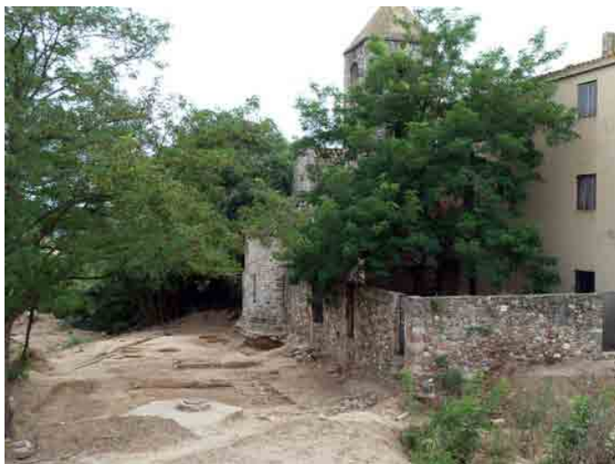
Vista de l'excavació una vegada finalitzada
